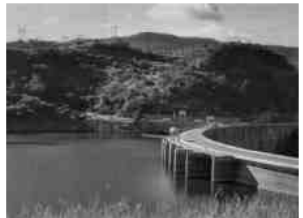
Der 1971 vollendete Staudamm am Kafue River – wichtig für unabhängige Energieversorgung des Landes
